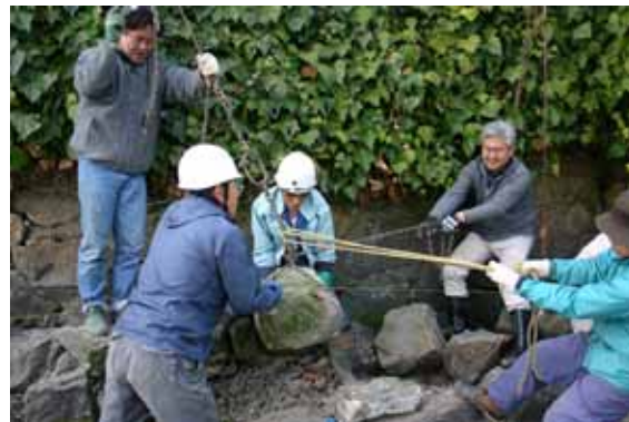
3月1日 石の積み直し作業
