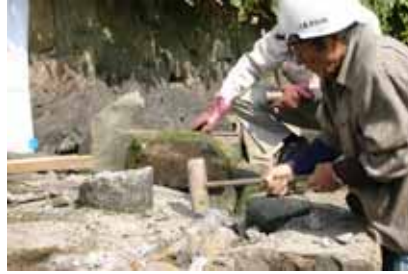
上部の欠けた舟つなぎ石. まわりのコンクリートを削る作業。
